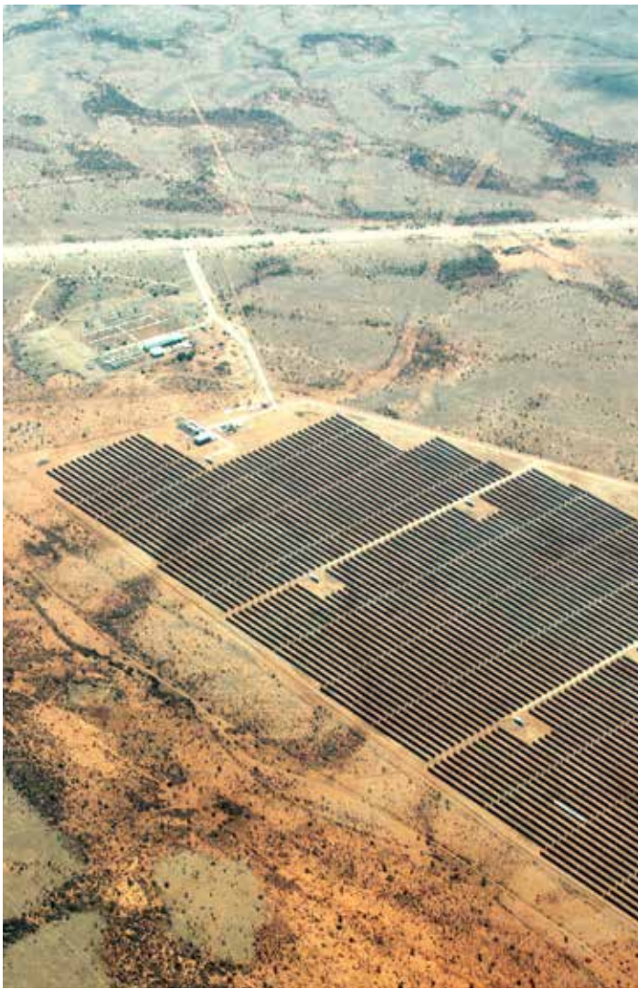
Das Solarkraftwerk Mariental in Namibia: Aus der Luft zeigt sich der enorme Flächenverbrauch hinter der „Grünen“ Energiewende.
